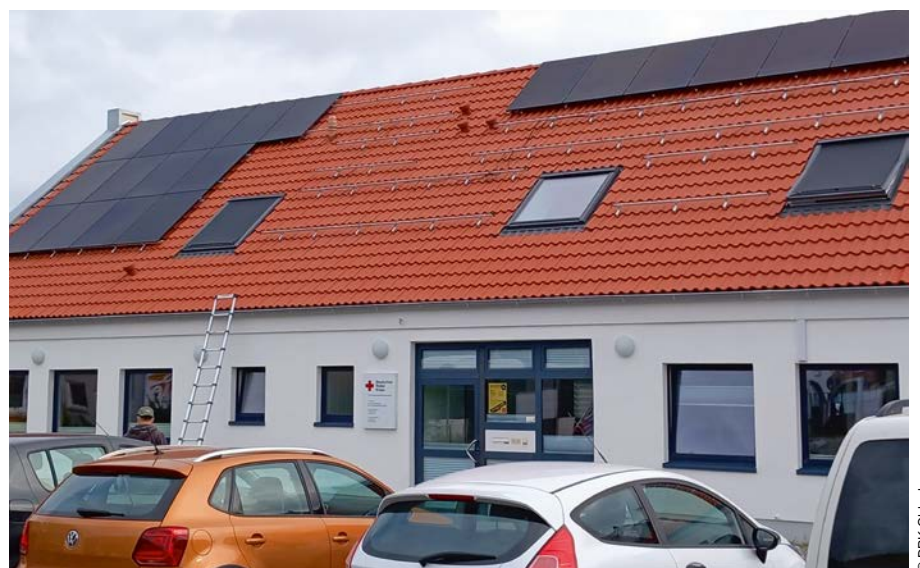
Die Photovoltaikanlage wird installiert
